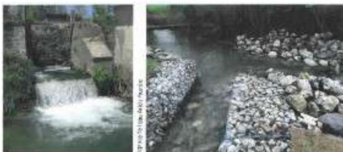
A gauche : ouvrage de M. Lafonte (ROE 26746) avec sa chute résiduelle de 2.06m sur le bras de Bronne, à Aix-en-Issart
